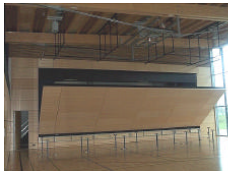
Die Bühnenwand wird mittels zwei parallel laufender Seilwinden sicher herabgelassen.
