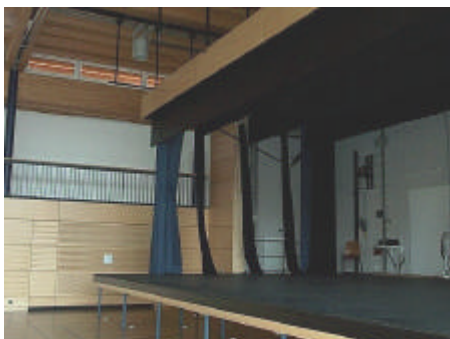
Das ausziehbare Deckenteil wird über ein Seilzugsystem in Theaterstellung gebracht.
