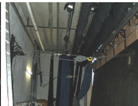
Die gesamte Bühnentechnik mit Vorhängen, Beleuchtung, Schallreflektoren usw. ist wie eine Harmonika zusammengefahren.
